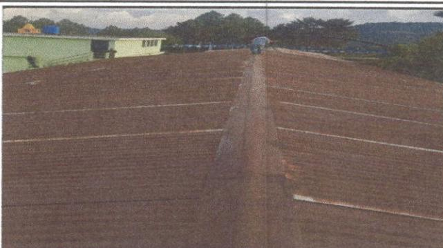
Foto 2: Sustrucción de capote para lámina troquelada
