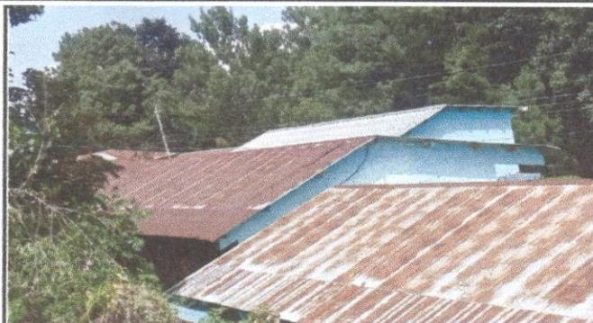
Foto 1: Sustrucción de lámina por lámina troquelada aluzinc C 26 (0.40mm)
